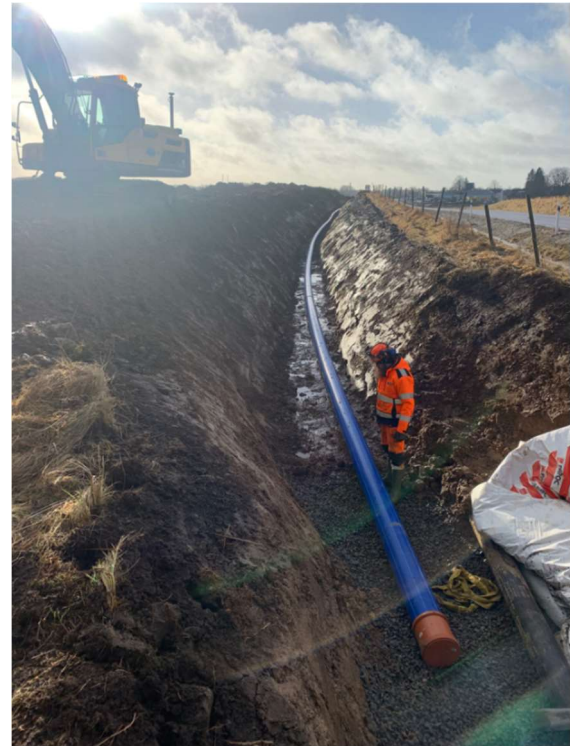
Nyläggning av vattenledning i Slutarp
