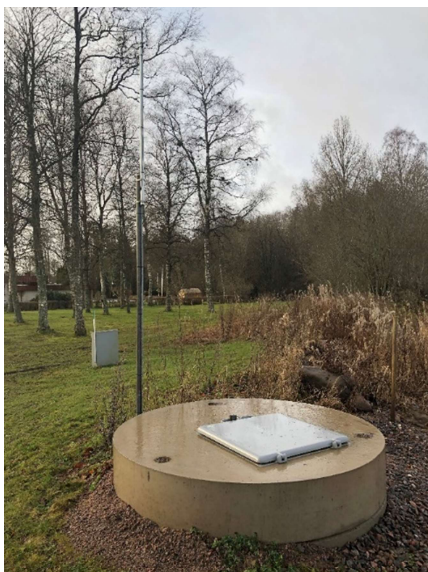
Vattenmätarbrunn med Lora antenn
