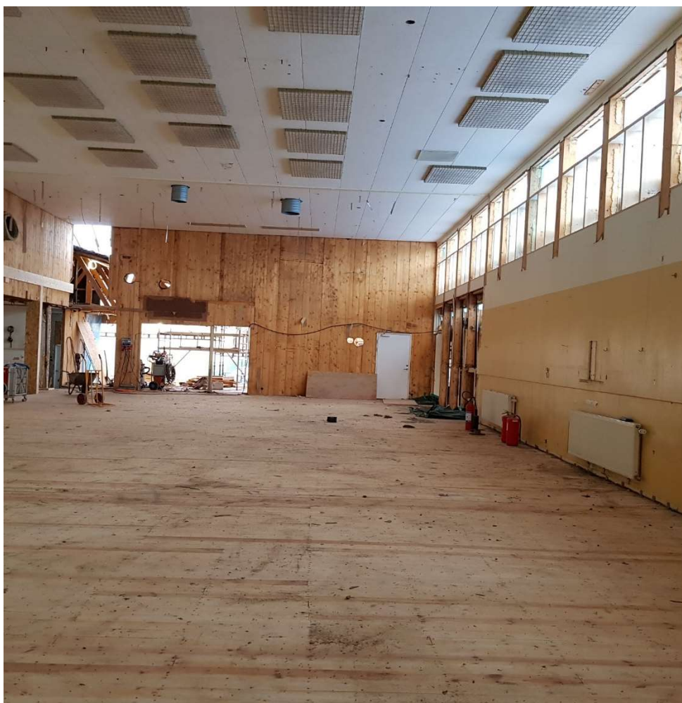
Under byggnation – Odensberg Förskola/kök
