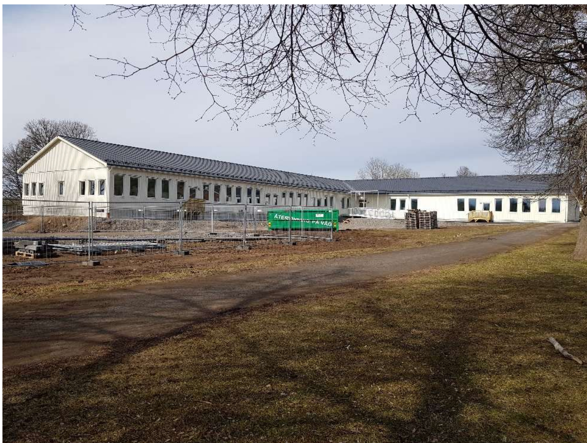
Prefabricerad skolbyggnad i Odensberg färdigställdes under våren 2022
