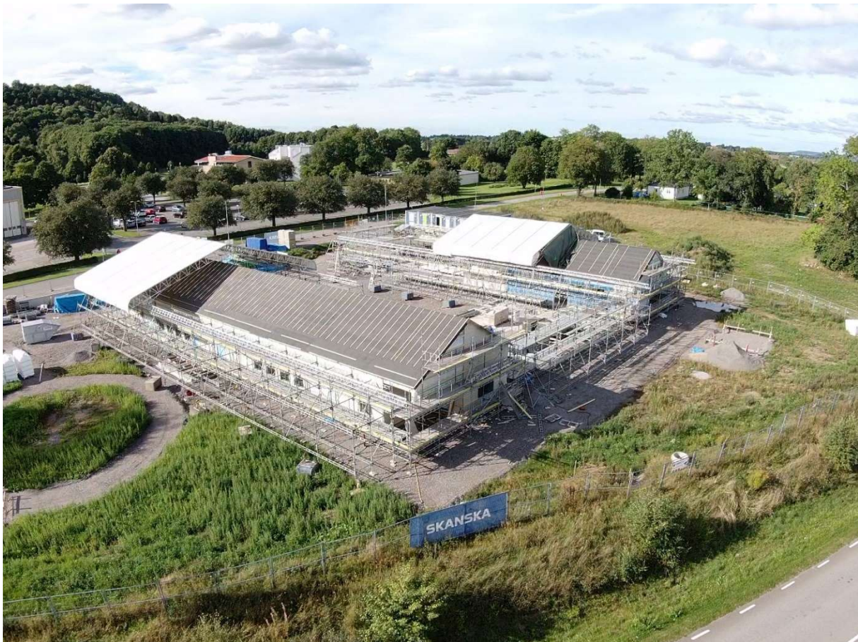
Byggnation av nytt korttidsboende på Jättenegatan
