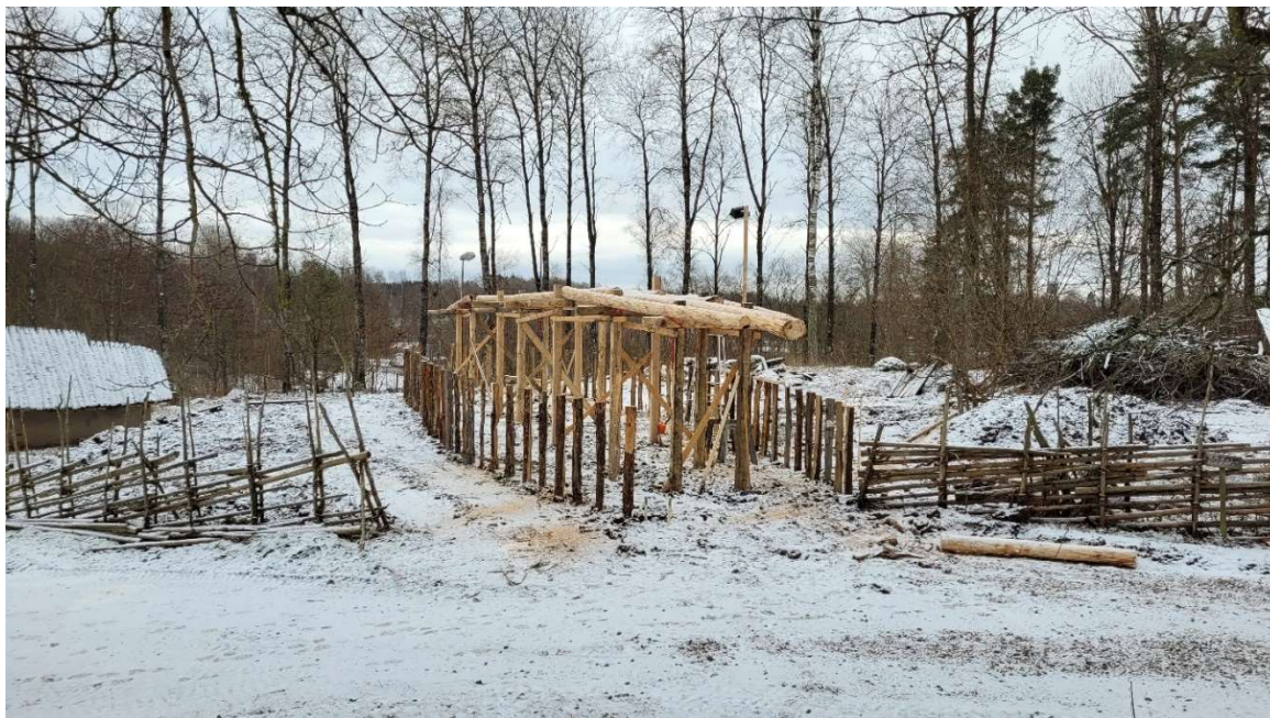
- Byggnation av järnåldershus i Ekehagens forntidsby
