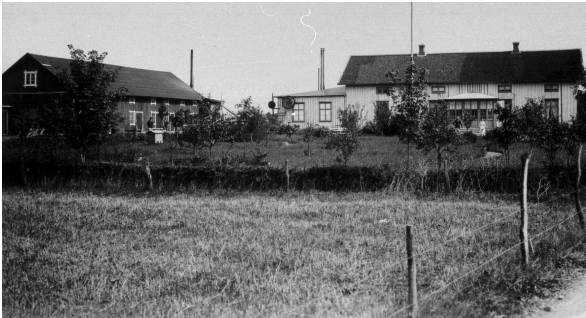
Ömans handelsbod, Aspenäs, Floby, 1916. I den låga tillbyggnaden till vänster fanns ett mejeri som också drevs av August Öman. På väggen skymtar en remskiva som tillsammans med en rem användes för att överföra kraft från ångmaskinen i ett uthus (skorstenen syns på bilden) till maskinerna i mejeriet. Byggnaden till vänster användes som lagerlokal och svinhus.
