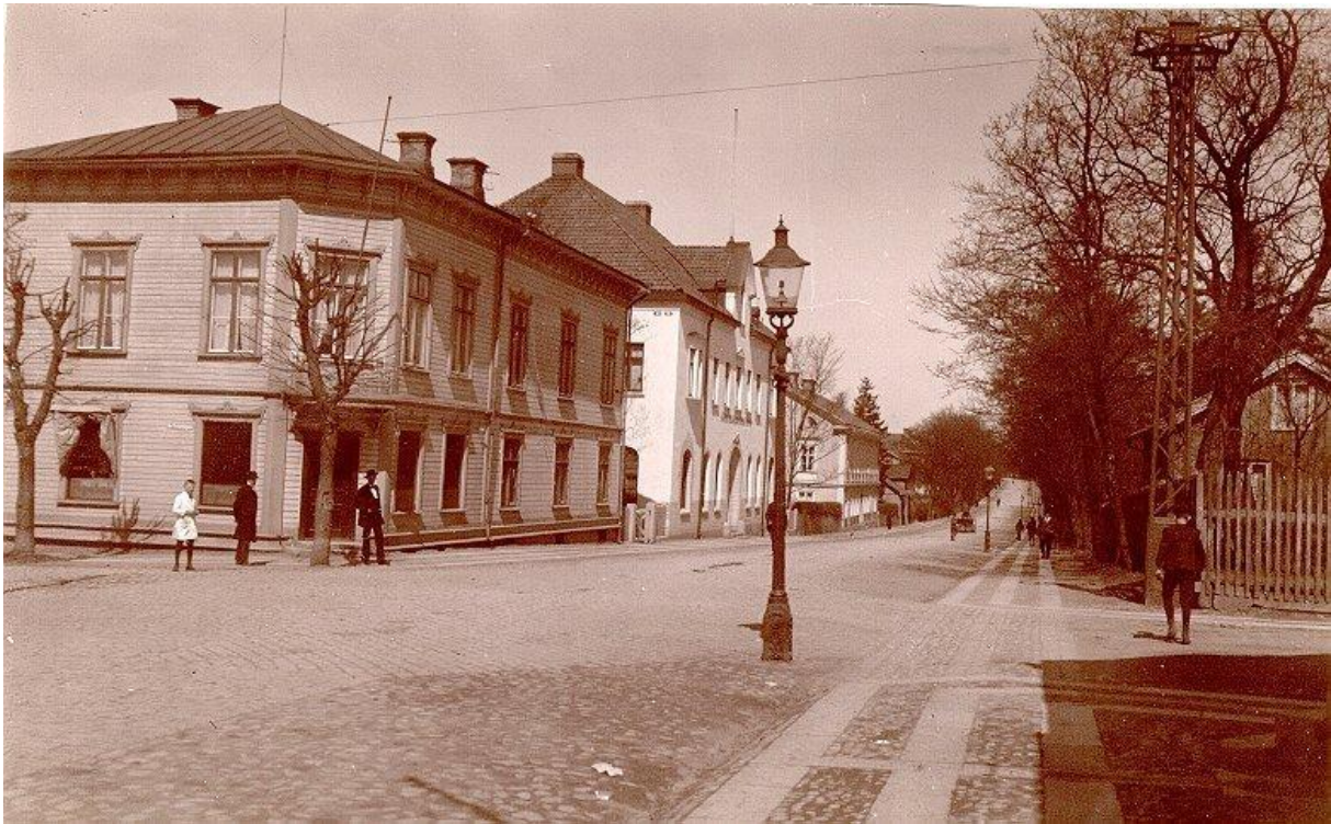
Gaslykta vid korsningen Järnvägsgatan (nu S:t Olofsgatan) och Trädgårdsgatan.
