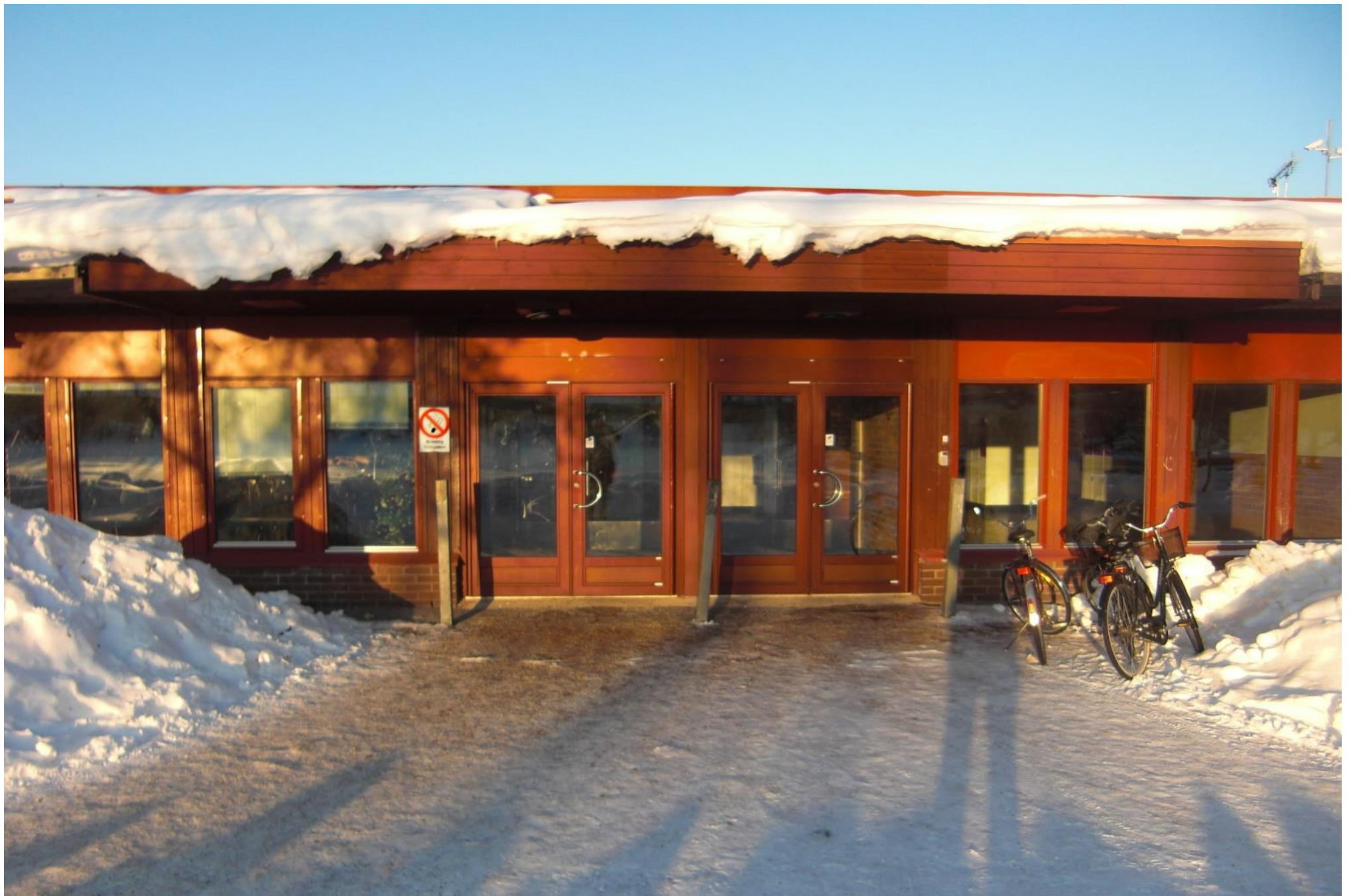
En av de äldre entréerna på långsidan.
