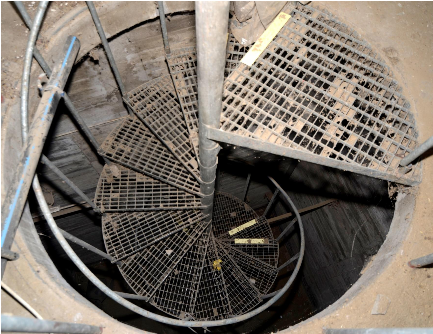
En trappa inne i silon.
