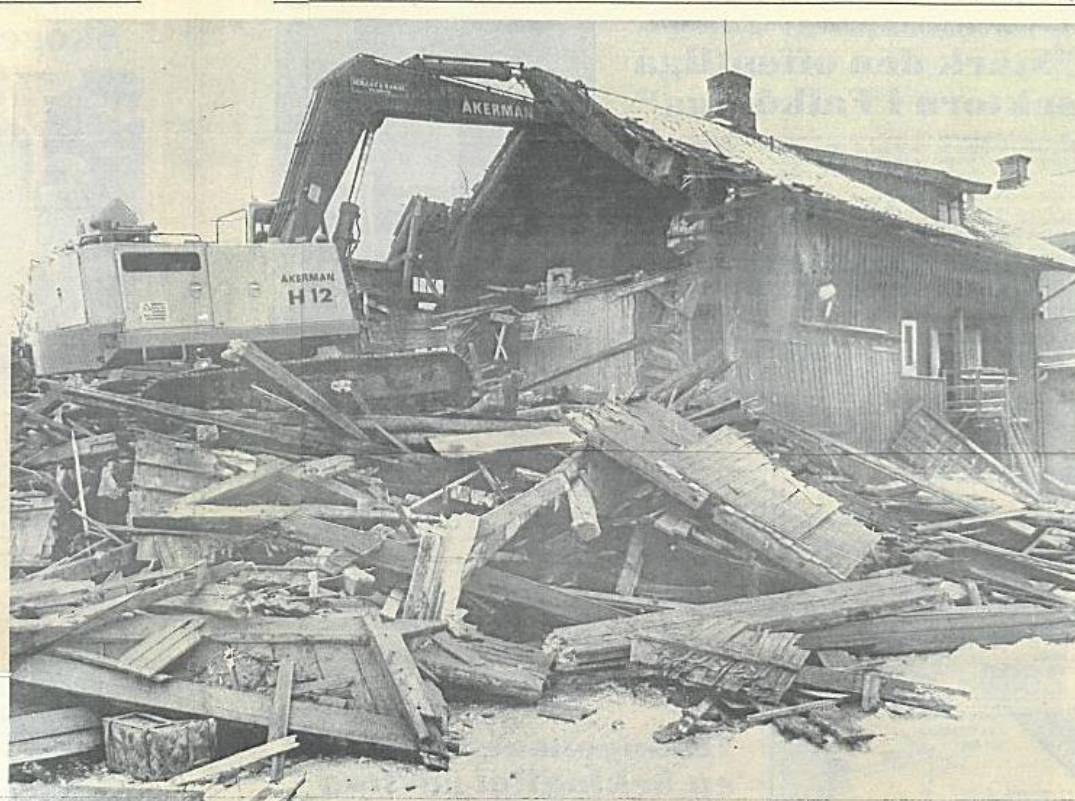
"Här rivs för att ge luft och ljus" skrev Strindberg. Kanske tillämpas även här i Kemisten där grävskopan rev de gamla 100-åriga långorna längs Köttorget och Nygatan.
