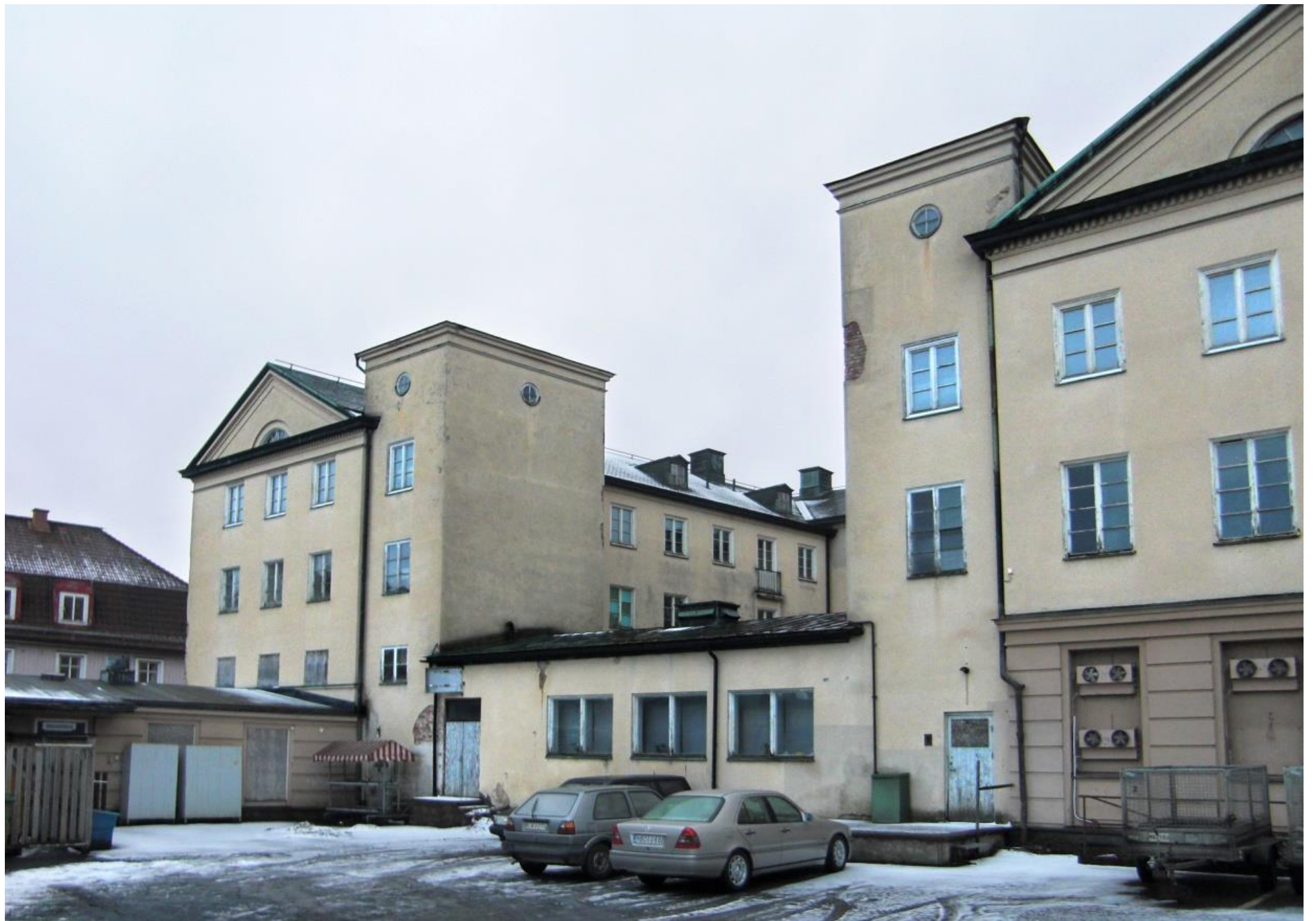
Hotellet från gårdssidan strax före rivningen.
