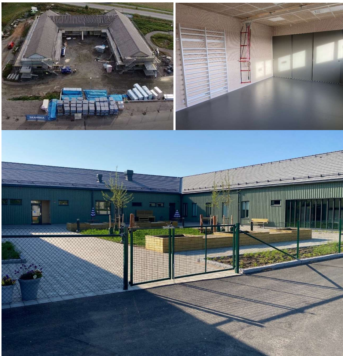
Flygfotot under byggnation, rörelsesal och entré
